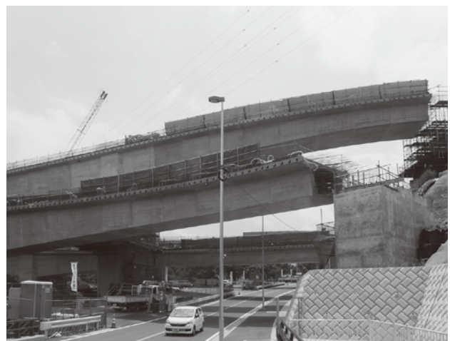
相模原ICは2014年度中の開通に向け工事中
